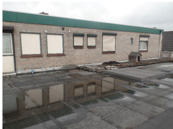
Achterkant gezien vanaf het dak van de aanbouw.
