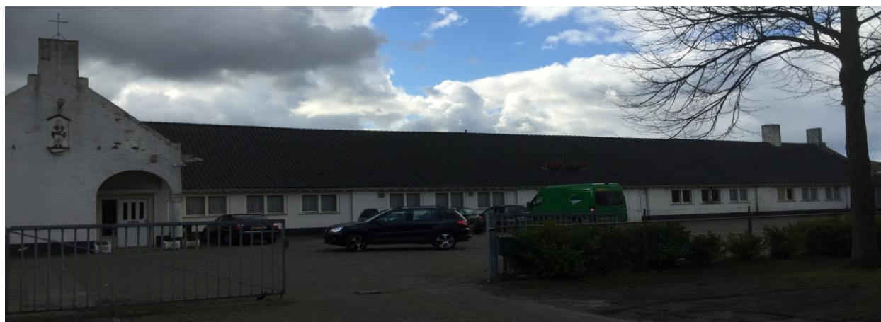
Figuur 1: Overzichtsfoto onderzoekslocatie.
