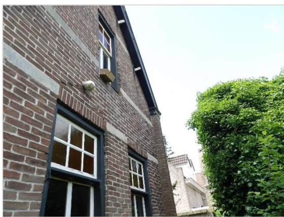
Foto 1: Onderzoek gevels en dak, Sint Janstraat 95
