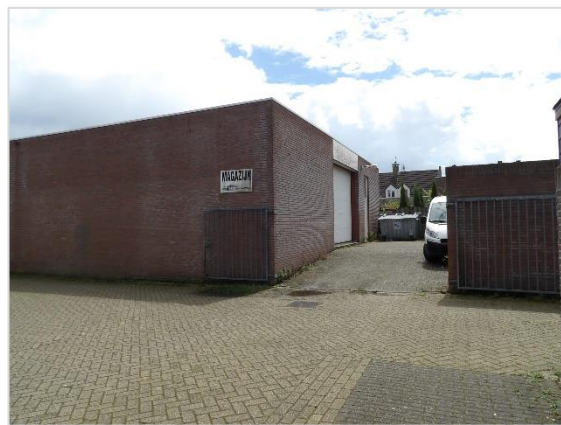
Foto 4: Onderzoek muren en stootvoegen magazijn, Sint Janstraat 97
