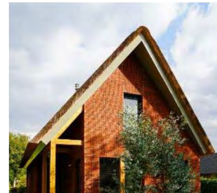
dakbedekking riet (m)
