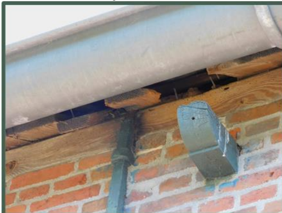
Ruimte onder de goot
