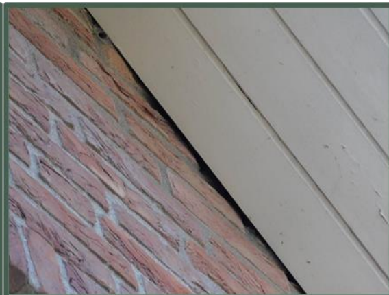
Ruimte tussen muur en betimmering
