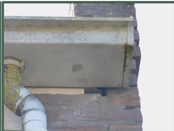
Ruimte onder de goot
