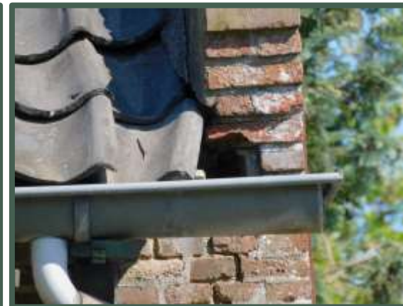
Gat in de muur, ruimte onder dakpan
