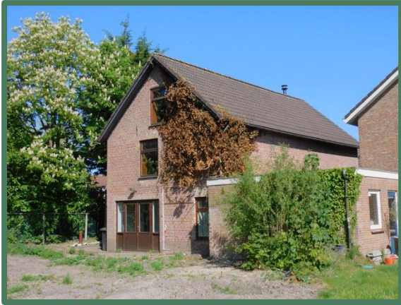
Achterzijde nummer 64a vanaf het zuidoosten
