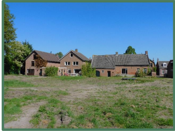
Achterzijde te slopen woningen aan St Jansstraat
