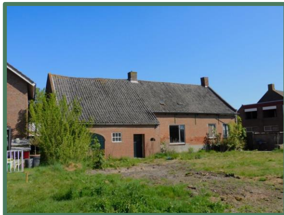
Achterzijde nummer 66 vanaf het zuiden
