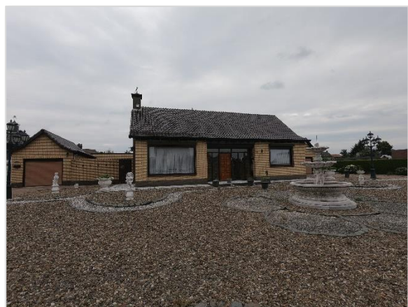
Foto 2: Impressie te slopen woning met opstallen Noorderstraat 16 te Sprundel.
