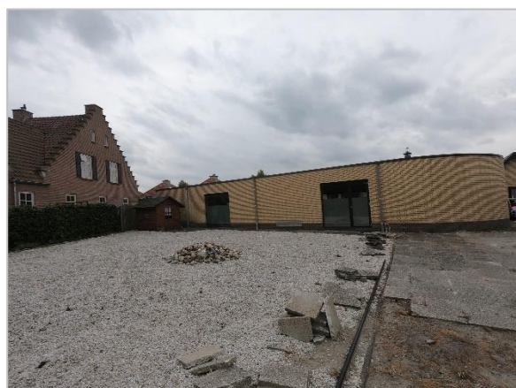
Foto 6: Te slopen overdekt zwembad aan oostzijde woning.
