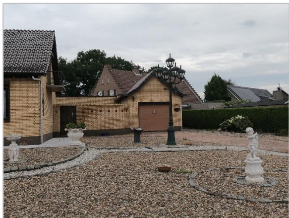
Foto 4: Te slopen garage/schuur aan zuidzijde woning.
