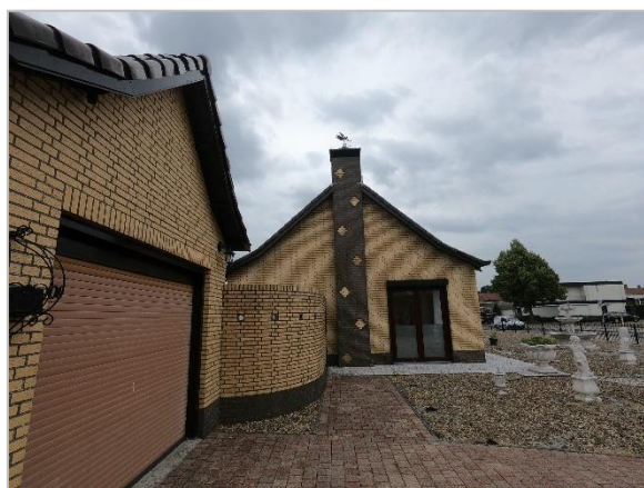
Foto 5: Te slopen garage/schuur aan noordzijde woning.
