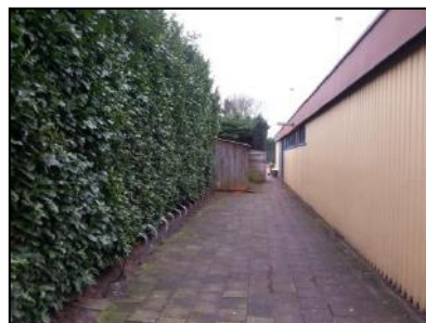
Figuur 4. Zijkant te verwijderen kantine, met toegangspad naar tennisbanen.
