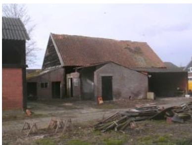
Foto 6: Zijaanzicht bijgebouw (2) vanuit achterterrein
