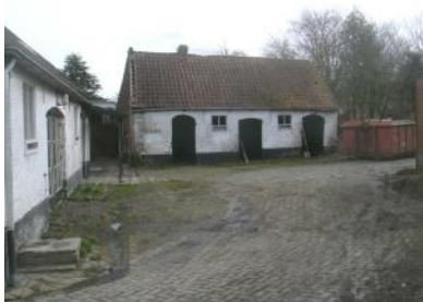
Foto 3: Bijgebouw (1) achter woning
