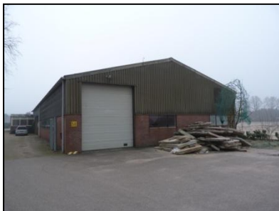
Figuur 3. Loods op de locatie.
