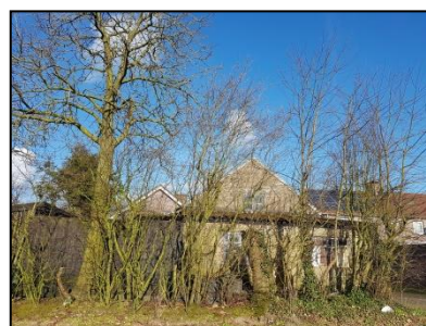
Figuur 8. Bomenrij met daarachter bebouwing aan de oostzijde van de onderzoekslocatie.
