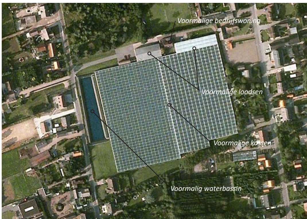
Detail luchtfoto van de locatie
