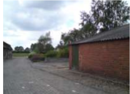
Met klinkers verharde oprit
