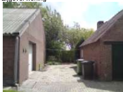
Werktuigenschuur met garage
