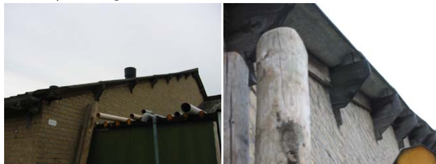
foto 11: noordelijke kalverenstal. Foto 12: detail smalle ruimte onder daklijst
