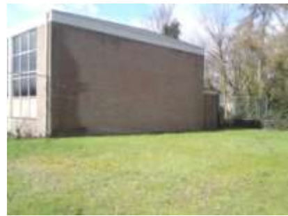
Achtergevel pand met op de voorgrond het sportveld
