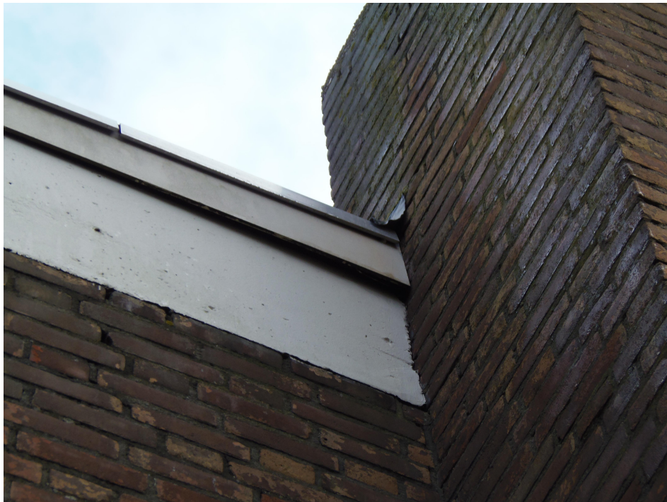
Figuur 4. Een van de locaties waar vleermuizen achter de houten betimmering en loodslabben het gebouw in kunnen kruipen.
