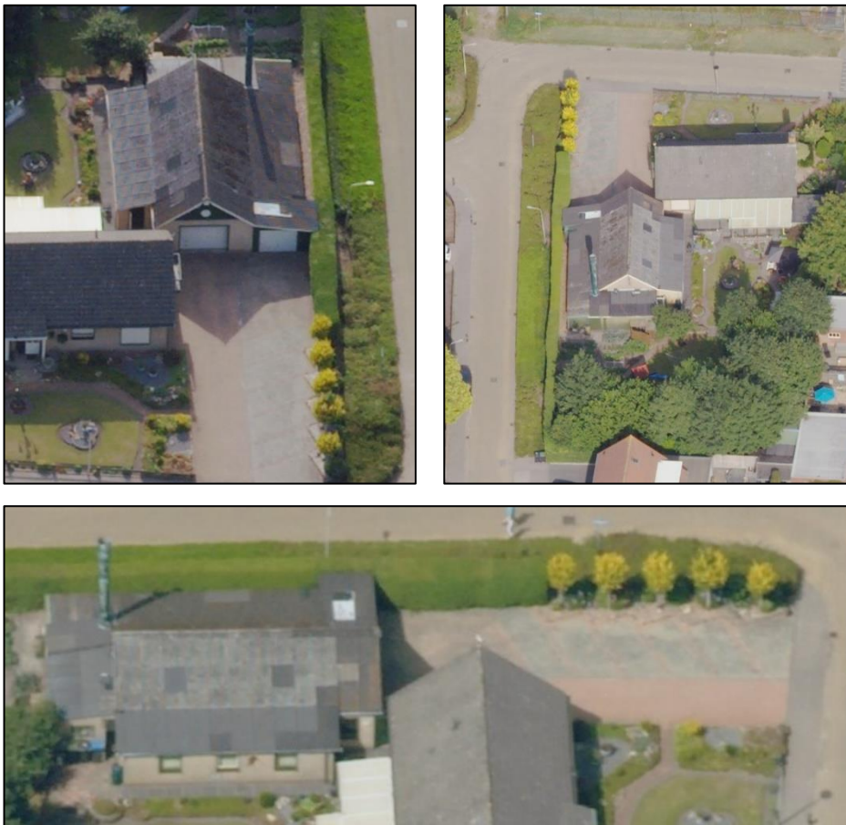
Luchtfoto's bedrijfsp perceel plangebied. Bron: Cyclomedia Technology BV, 2022.
