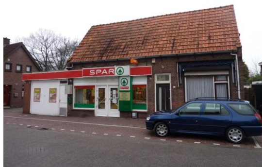
Figuur 3 Bestaande supermarkt op planlocatie
