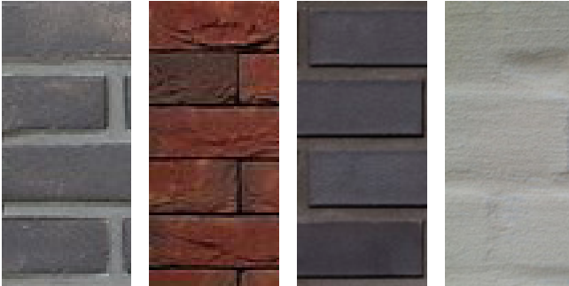
verschillende kleuren baksteen
