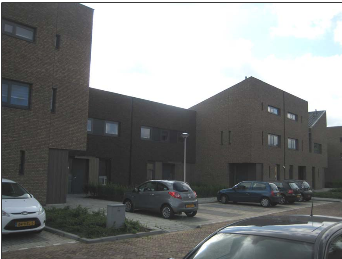
Herstructurering woningen Van Marxhemstraat en Oranje Nassaustraat.
