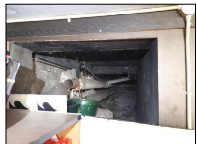
Figuur 8. Detail leidingschacht kelder.
