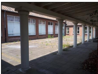
Figuur 6. Binnenplaats rechtervoorzijde gebouw.
