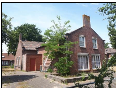
Figuur 3. Linkerkant van de voorzijde van het gebouw.
