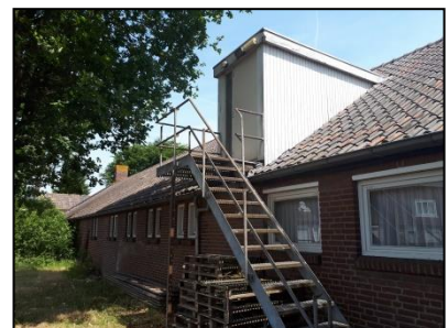
Figuur 5. Achterzijde gebouw.
