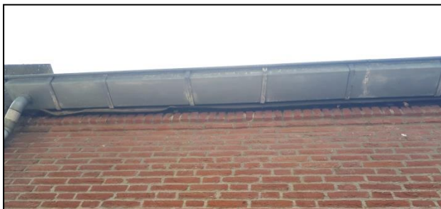
Figuur 9. Detailopname dakrand.
