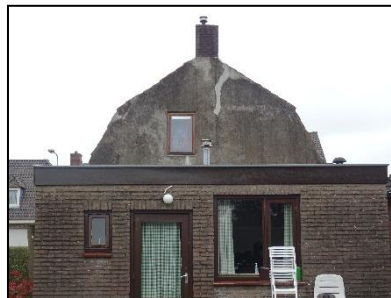
Figuur 4. Woonhuis, gezien vanaf de westzijde.
