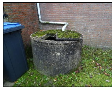
Figuur 11. Ommuurde put ten westen van de garage in de achtertuin, gezien vanaf het noorden.
