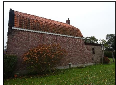
Figuur 5. Woonhuis, gezien vanuit de tuin op de onderzoekslocatie, vanaf de noordzijde.
