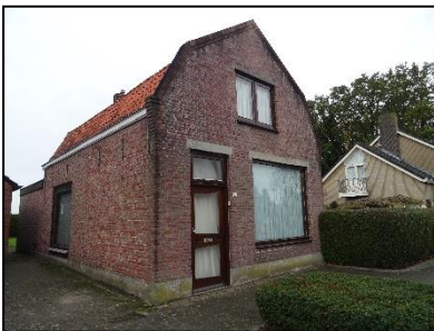
Figuur 3. Woonhuis onderzoekslocatie, gezien vanaf het zuidoosten.
