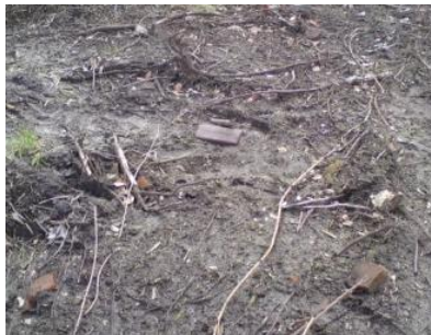
Puinresten ter hoogte van de voormalige bebouwing.
