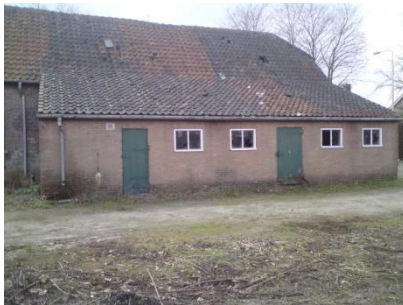
Achterzijde stalgedeelte boerderij
