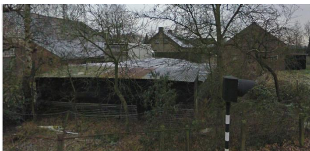
Reeds gesloopte stallingsruimte tractor en kippenhok (Bron: 10, Google Earth, Streetview, 12-2009)
