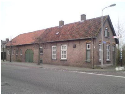
Vooraanzicht langgevelboerderij, gezien vanaf de Gebrande Hoefstraat
