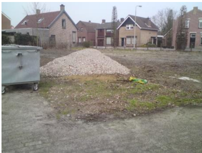
Puinlaag en repac ter plaatse van de mestplaat.
