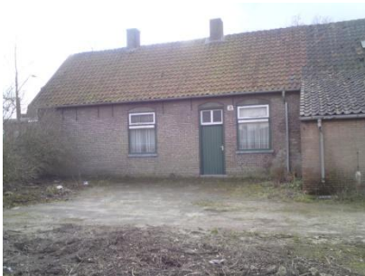
Achterzijde woongedeelte boerderij
