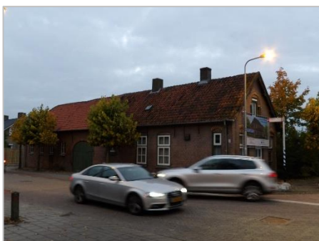
Foto 7: Slooppand aan kruising Gebrande Hoefstraat / St. Martinusstraat
