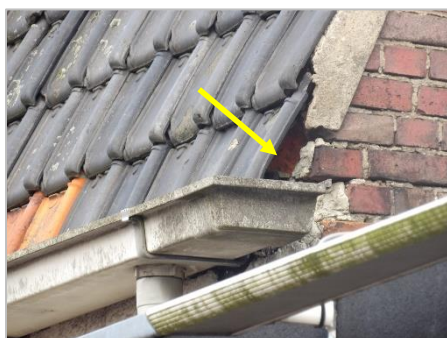
Foto 44: Bestaande woning aan St. Martinusstraat met openingen voor vleermuisverblijf
