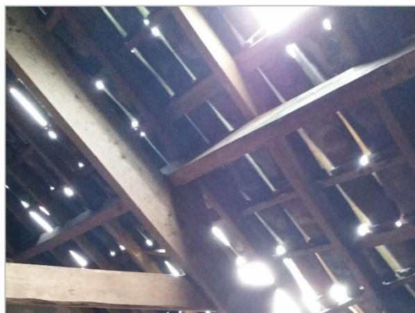
Foto 40: Dakbedekking zolder boven deel
