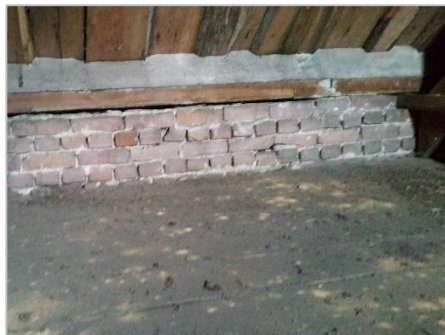
Foto 27: Tussenzolder (kieren bij dakrand)
