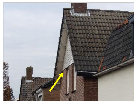
Foto 46: Bestaande woning aan St. Martinusstraat met openingen voor vleermuisverblijf
