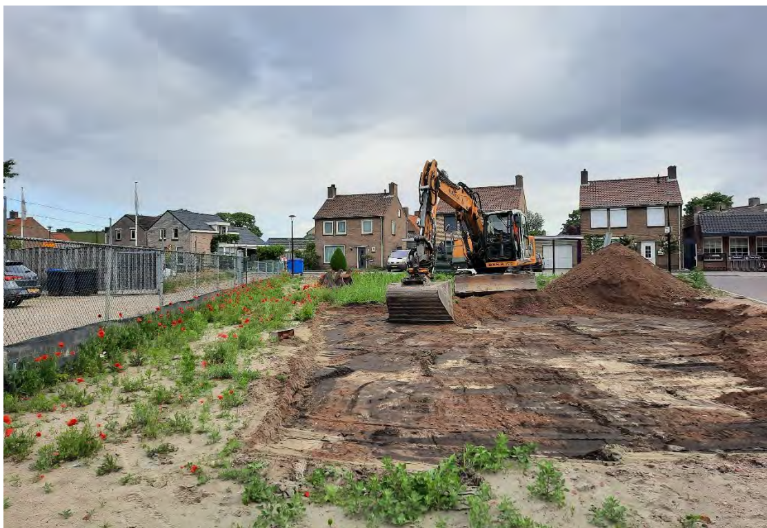
Figuur 2. Recent opgebrachte zandlaag wordt verwijderd voor aanvang van de aanleg van werkput 1 (gezien richting het noorden).
