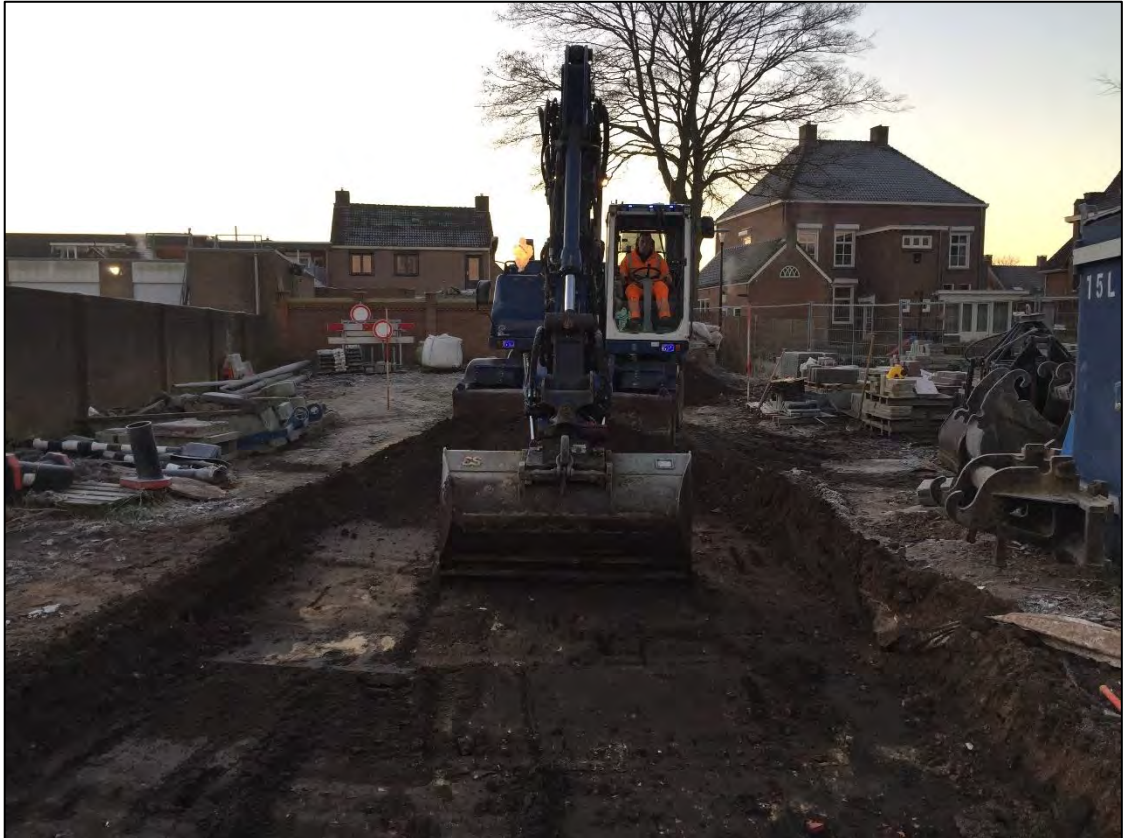
Figuur 2: Sfeerfoto van de aanleg van werkput 1. (Fotograaf: M. Sonneveld).
