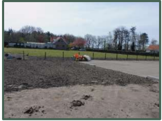
Bouwlocaties vanaf west
