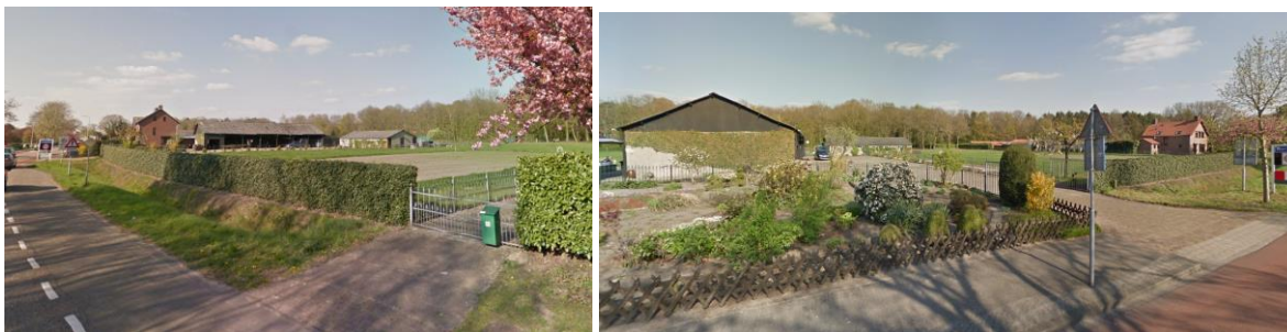
Figuur 13: Zicht vanaf de Zundertseweg (bron: Google 2019)
