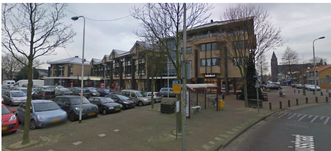
Zicht op de oostgevel (Schijfse Vaartkant) waarachter zich de woonkamers bevinden
