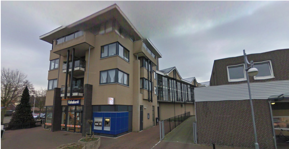
Zicht op de noord- en westgevel van het appartementengebouw vanaf de Raadhuisstraat. De westgevel bestaat uit de galerijen om de appartementen te ontsluiten en slaapkamers (niet zijnde de hoofdwoonvertrekken)
