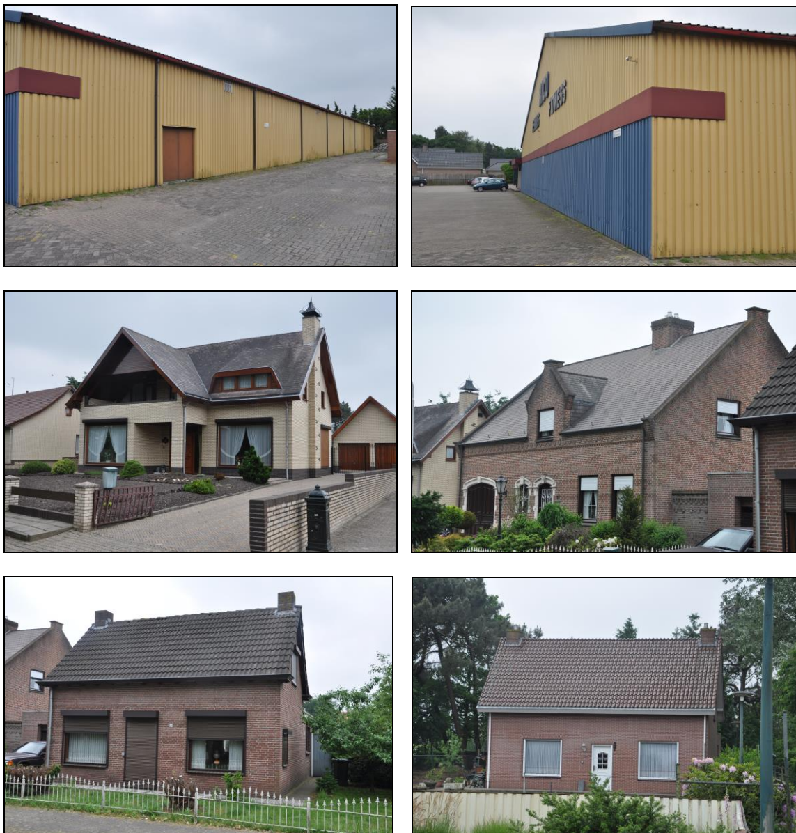
Figuur 2. Foto-impressie van te slopen / beïnvloede bebouwing.
