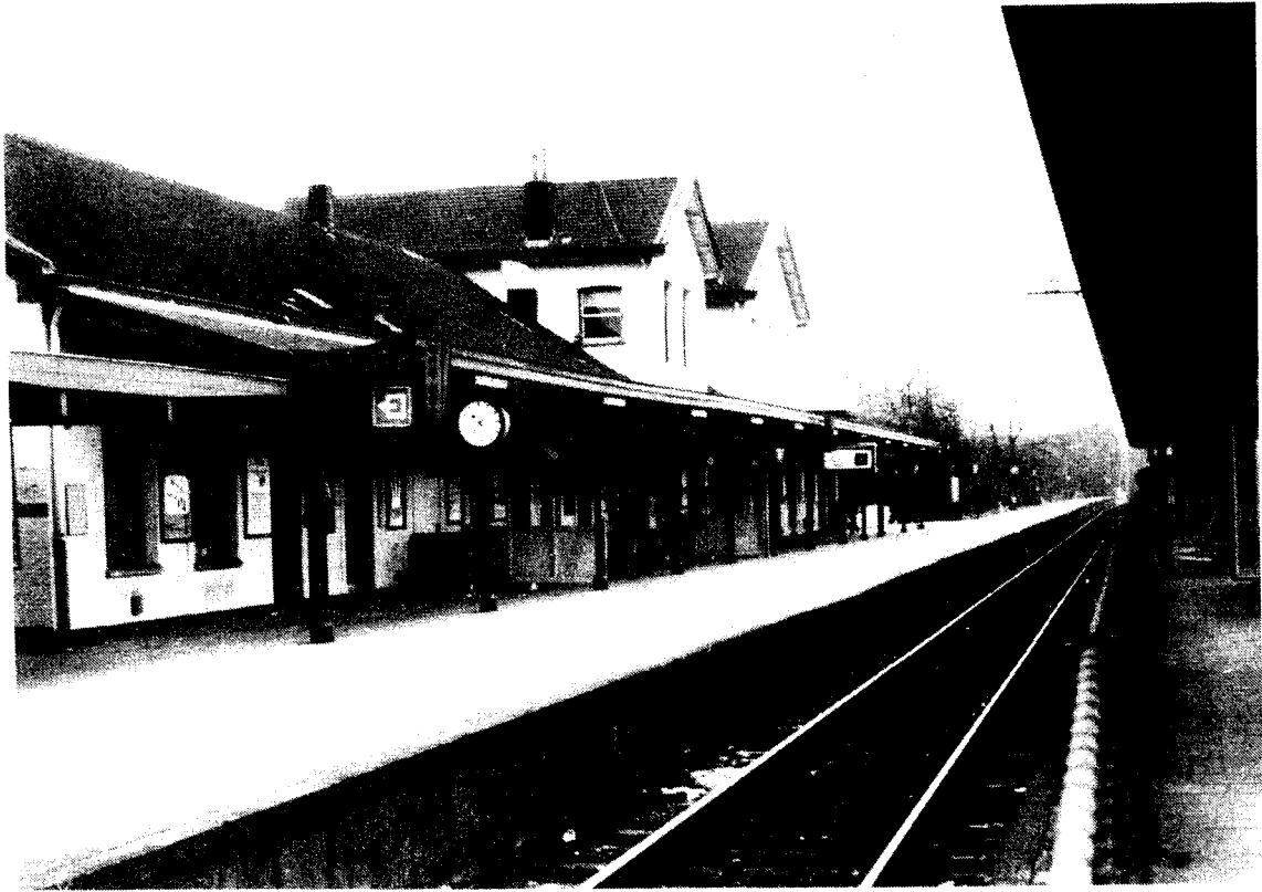
Het huidige station, dat gebouwd werd in 1881
