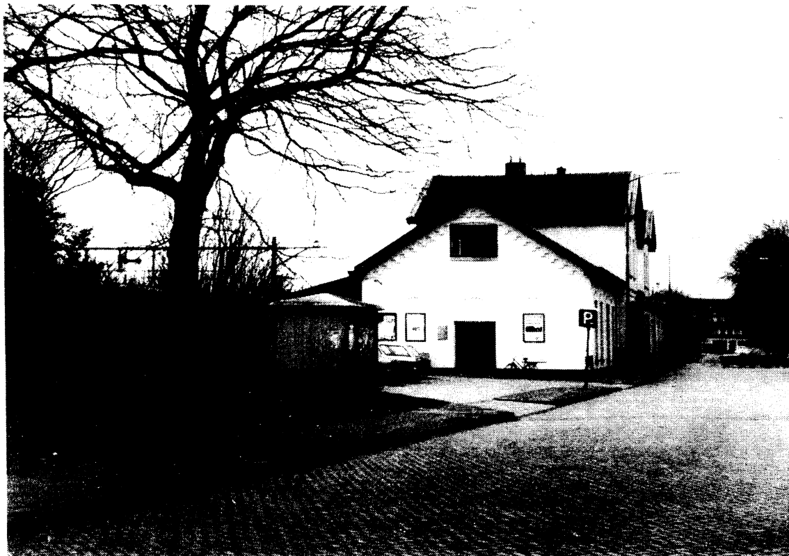
Het huidige station, gezien vanuit het oosten.
