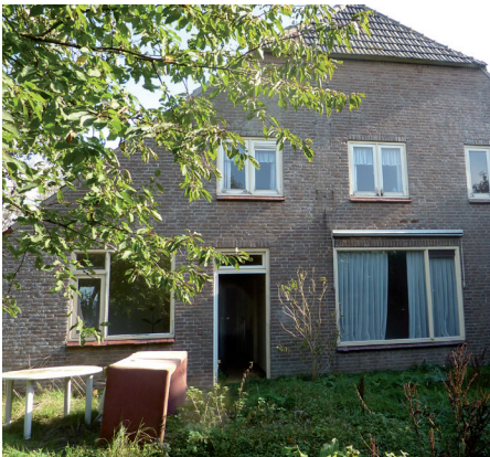
De westgevel (voorhuis) van de boerderij
