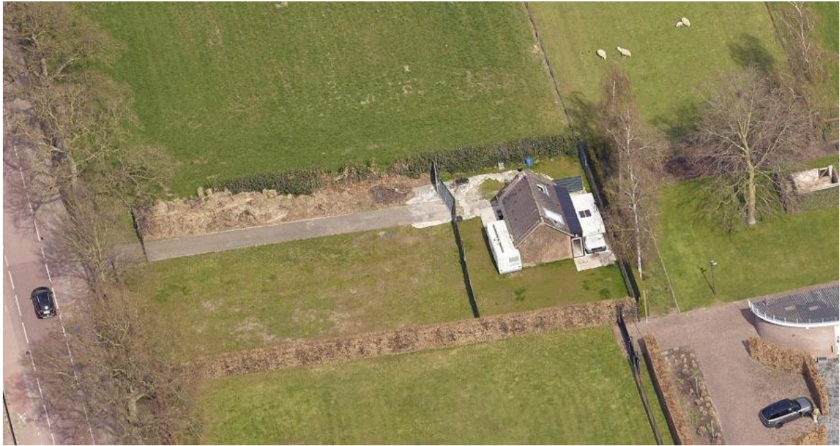
Situatie woning na de brand (huidige situatie)
