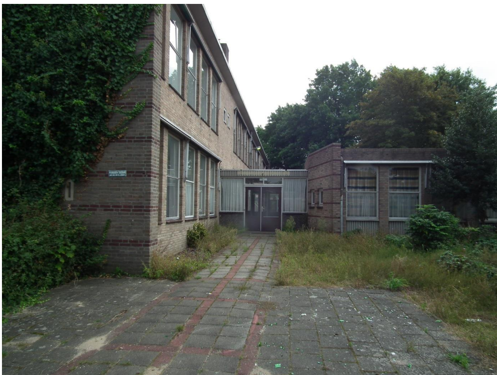
Figuur 2 De initiatiefnemer de gemeente Oss is voornemens de gehele locatie inclusief bebouwing te saneren. Beide gebouwen verkeren in een matig tot slechte staat van onderhoud.
