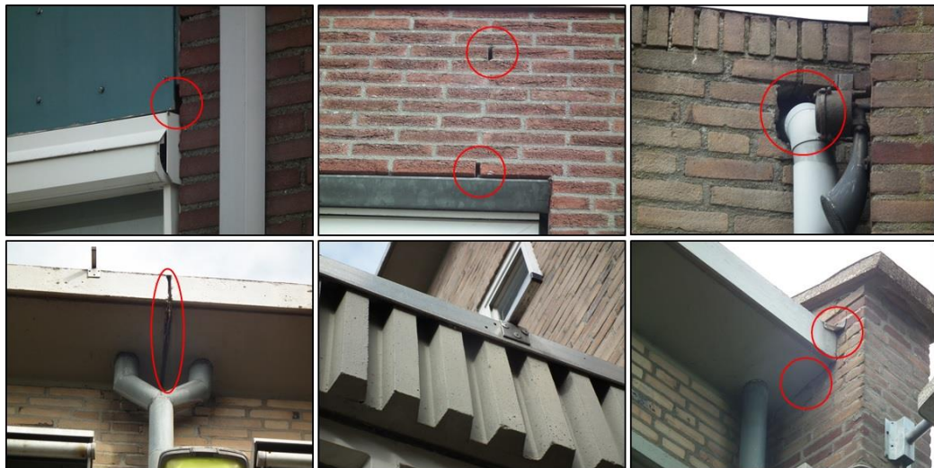
Figuur 2 Potentie van de bebouwing voor vleermuizen ten tijde van het oriënterend onderzoek.
