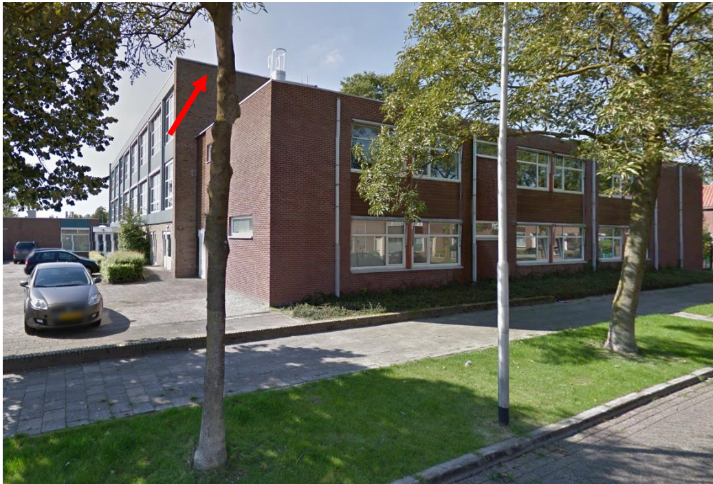
Figuur 3 De oostgevel vanaf de Doctor Hoebenstraat te Oss De kraam- en zomerverblijfplaats bevindt zich achter een open stootvoeg vlak onder de dakrand (bron; google.maps.nl)
