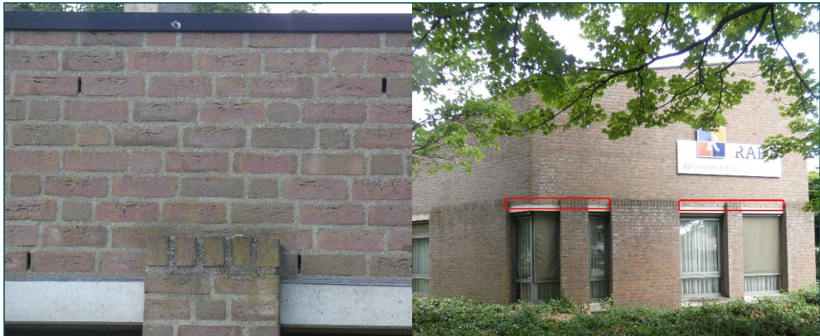
Figuur 3.1 Stootvoegen leiden tot de open spouwmuur, waar mogelijk geschikte verblijfplaatsen voor vleermuizen aanwezig zijn.
