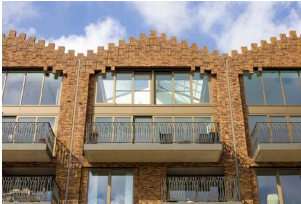
Sprekende overgang dak - gevel
