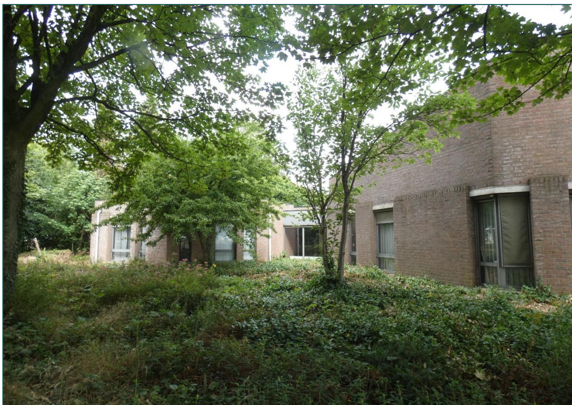
Figuur 3 De bebouwing met rondom aangeplant plantsoen.
