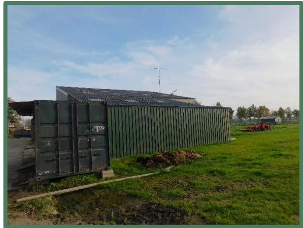
Achterzijde loods en stal met container
