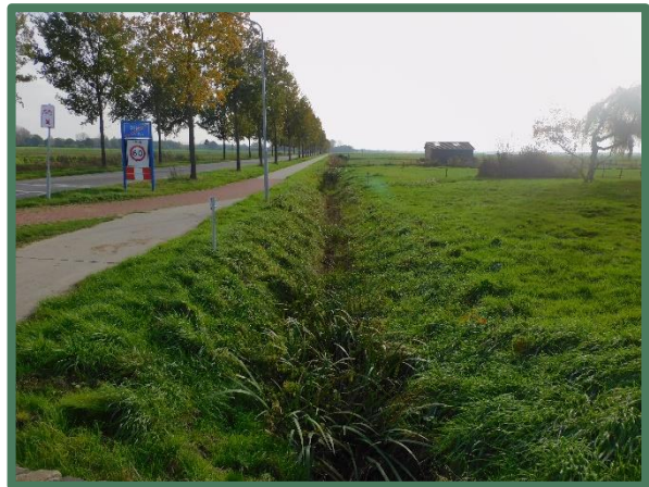
Sloot langs fietspad en berm Bernhardweg
