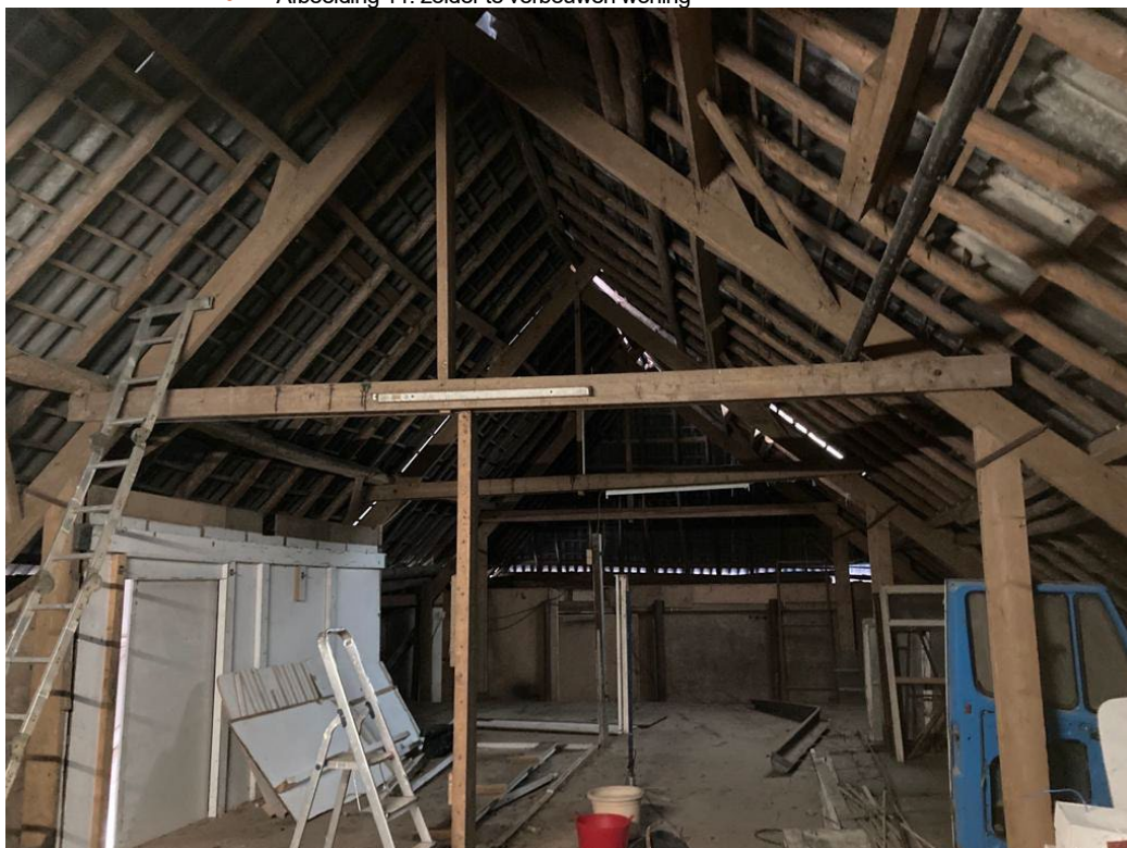
• Afbeelding 11: zolder te verbouwen woning
