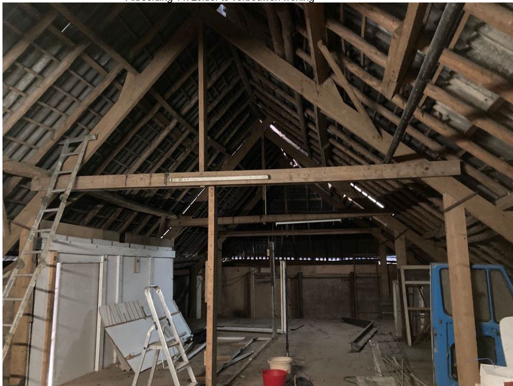
• Afbeelding 11: zolder te verbouwen woning
