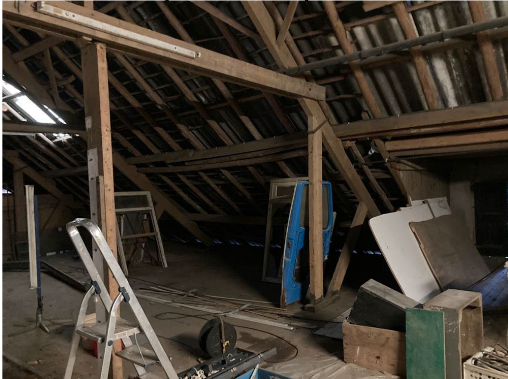
• Afbeelding 13: zolder te verbouwen woning
