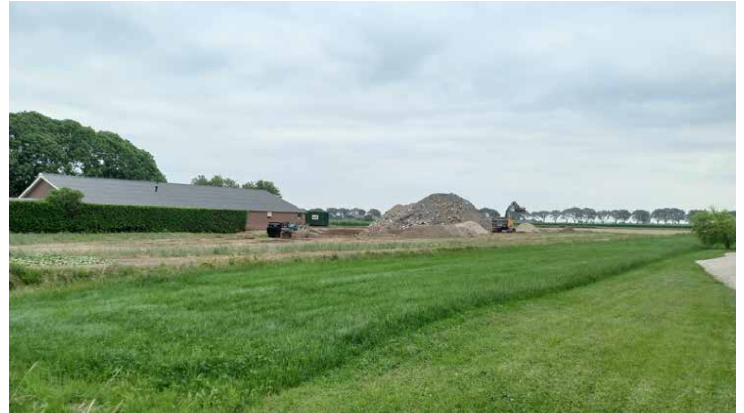
Zicht op erf vanuit het westen - erfbeplanting op zuidelijk deel herstellen na opruimwerkzaamheden.
