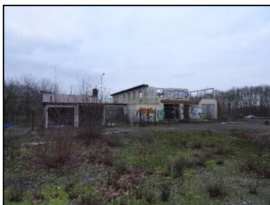
Figuur 3. Overzicht bebouwing, foto vanuit het westen.
