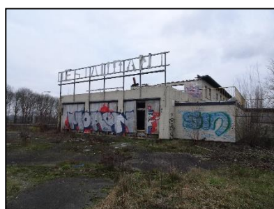
Figuur 7. Overzicht bebouwing, foto vanuit het oosten.
