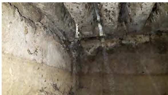
Stal 2, constructie mestputten onderzocht, geen asbestverdachte materialen aangetroffen
