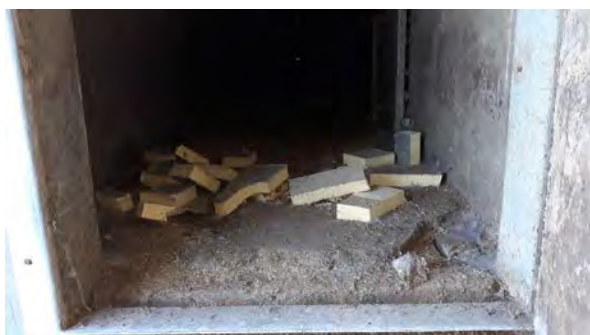
Stal 1, gangpad op betonroosters gestort
