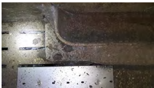
Stal 2, trog niet asbestverdacht
