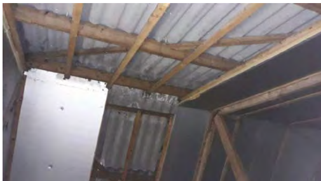
Foto 3 (de onderzijde van het dak is deels afgewerkt met Dupanel beplating)
