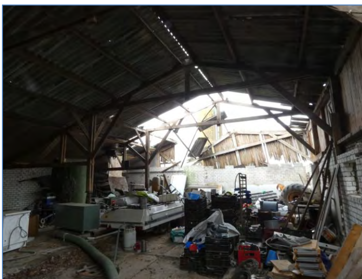
Foto 35 Gebouw 2 van binnenuit vanaf NW gezien
