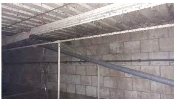
Stal 1, leidingen niet asbestverdacht
