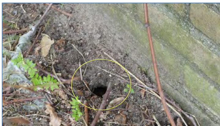
Foto 37 hol naast westgevel gebouw 1a
