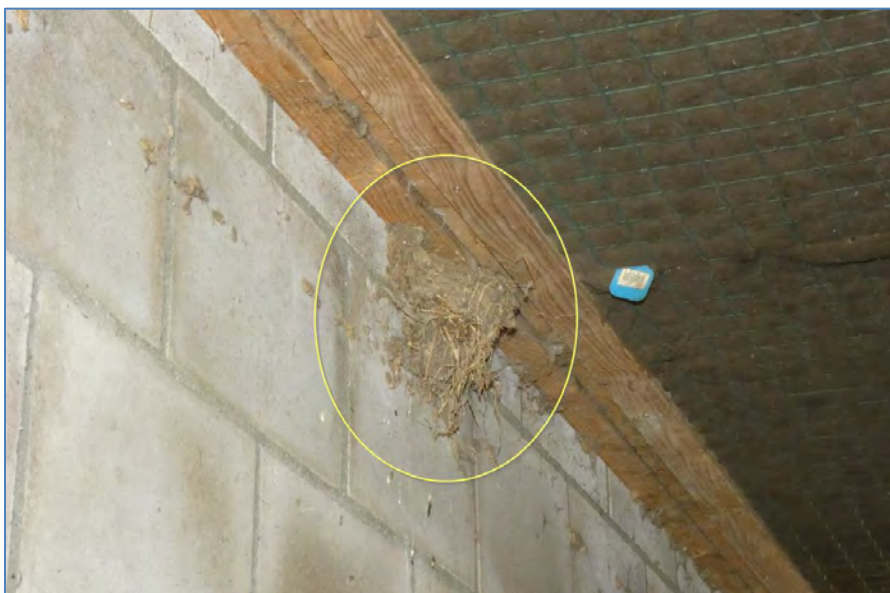
Foto 5 oud nest boerenwaluw doorloopgang gebouw 3
