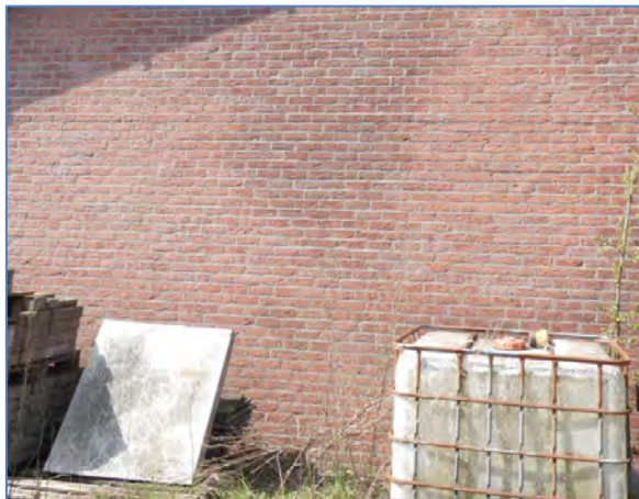
Foto 29 Zijgevel N gebouw 3 zonder open stootvoegen Foto 30 Voorgevel O gebouw 4 zonder open stootvoegen
