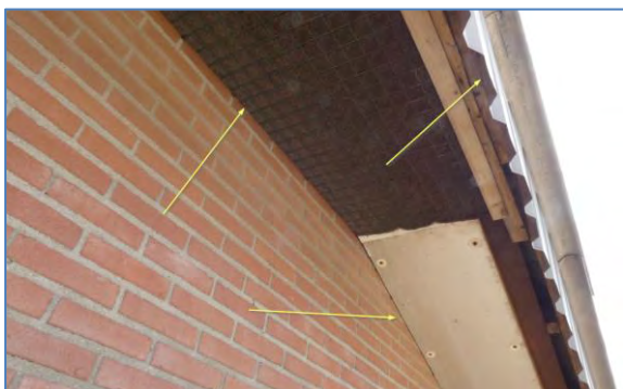
Foto 18 strakke afdichting kopgevel W gebouw 3
