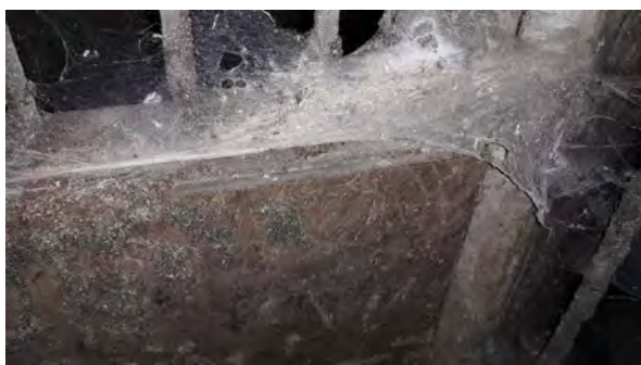
Stal 1, Trespa platen deuren biggenstal
