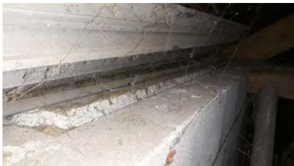
Schuur, geëxpandeerd polystyreen isolatie garage
