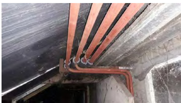
Schuur, leidingen, niet asbestverdacht
