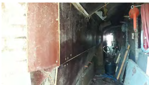
Schuur, houten aftimmering ventilatie binnenzijde
