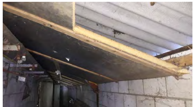
Foto 2 (de onderzijde van het dak is afgewerkt met Dupanel beplating)
