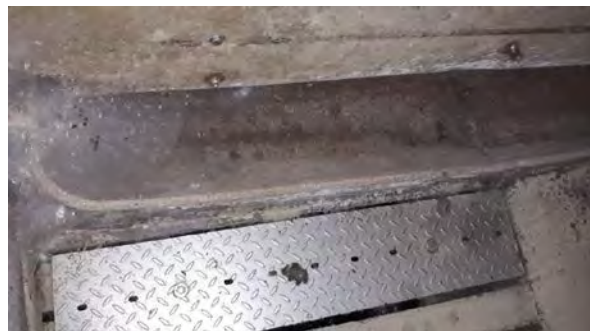
Schuur, beton trog, niet asbestverdacht
