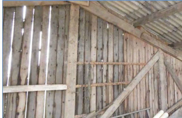
Foto 35 open bovenzijde westelijke spouwmuur gebouw 2 Foto 36 Houten, kierige topgevel
