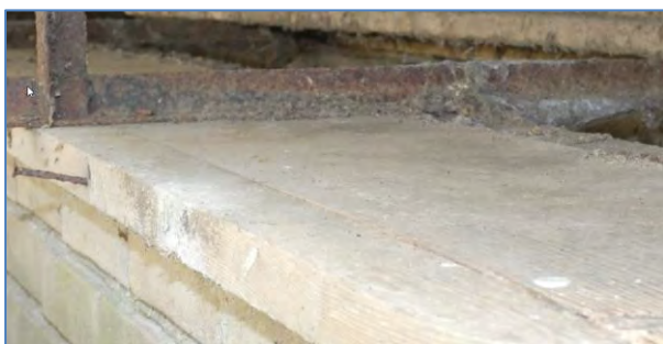
Foto 32 dichte spouwmuur gebouw 1a
