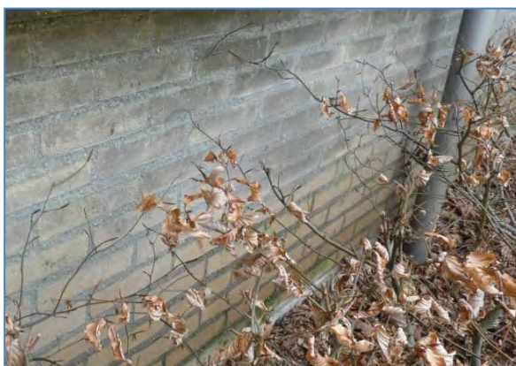
Foto 27 Zijgevel N gebouw 1a zonder open stootvoegen
