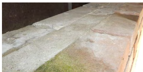
Foto 33 dichte spouwmuur gebouw 1b
