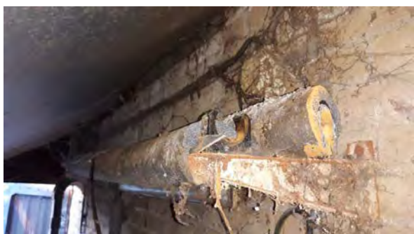
Schuur, leidingisolatie, niet asbestverdacht
