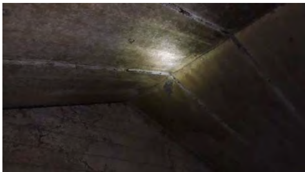
Foto 3 (de onderzijde van het dak is afgewerkt met Dupanel beplating)
