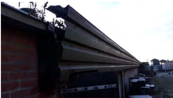
Stal 2, metalen ventilatie
