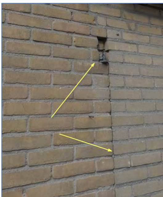
Foto 26 Dichte krimpvoeg voorgeven geb. 1a – 1
