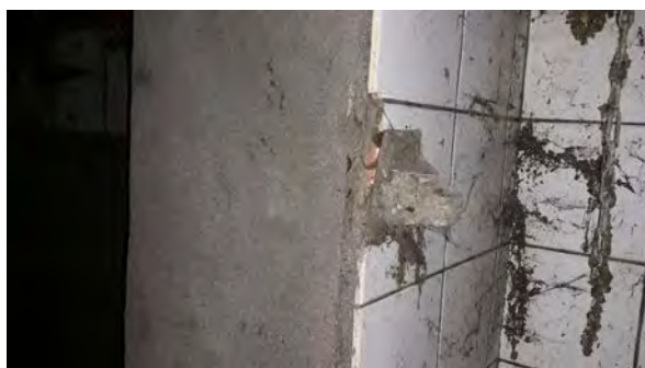
Stal 1, tegels in cement gezet (geen asbestverdachte tegellijm aangetroffen)
