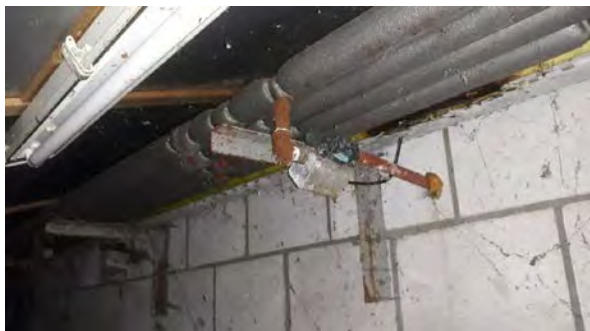
Stal 1, leidingisolatie niet asbestverdacht
