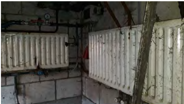
Stal 2, radiatoren niet asbestverdacht
