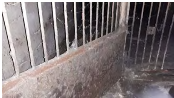
Stal 1, Trespa platen deuren biggenstal
