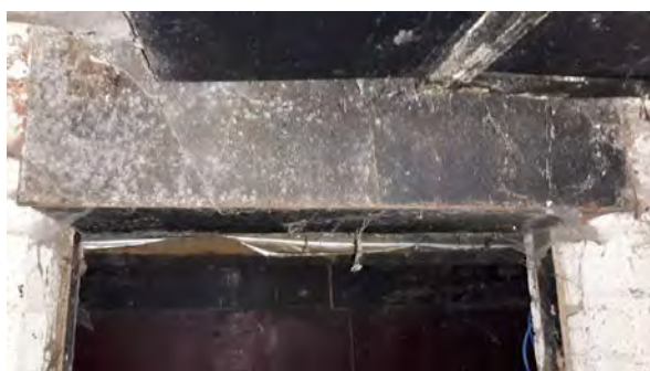
Schuur, houten aftimmering boven deur
