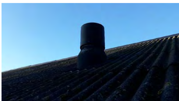
Schuur, PVC ventilatie buizen
