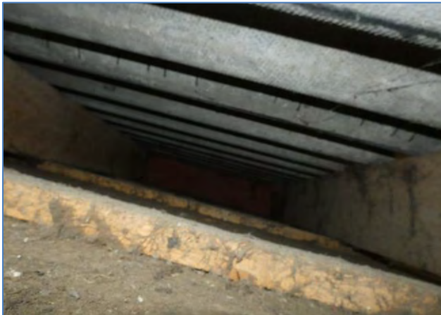
Foto 24 geheel lege ruimtes boven isolatiemateriaal gebouw 4
