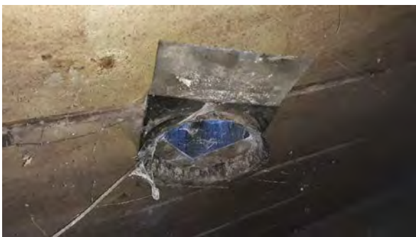
Stal 2, PVC ontluchting
