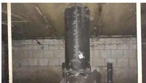
Stal 1, PVC ontluchting
