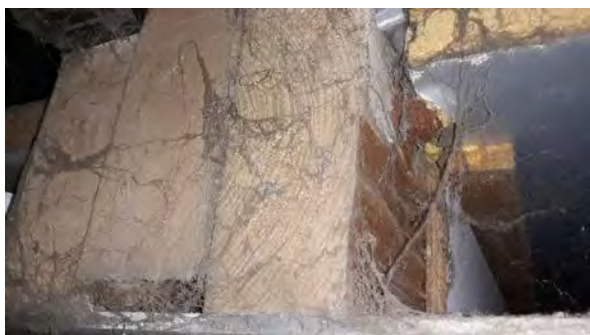
Schuur, houten balken achter aftimmering
