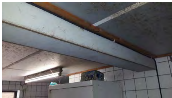
Schuur, houten balken achter aftimmering
