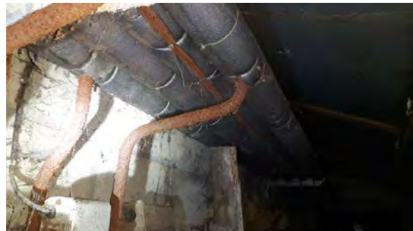
Stal 2, leidingisolatie niet asbestverdacht
