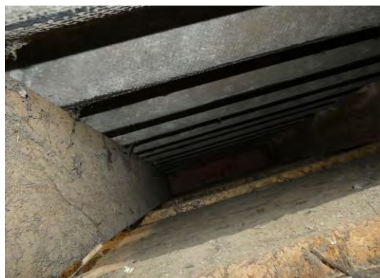
Foto 23 geheel lege ruimtes boven isolatiemateriaal gebouw 4
