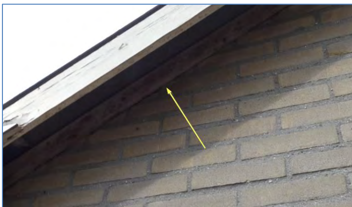
Foto 13 kopgevel stal 1b met afdichtingslat tegen dak-beplating
