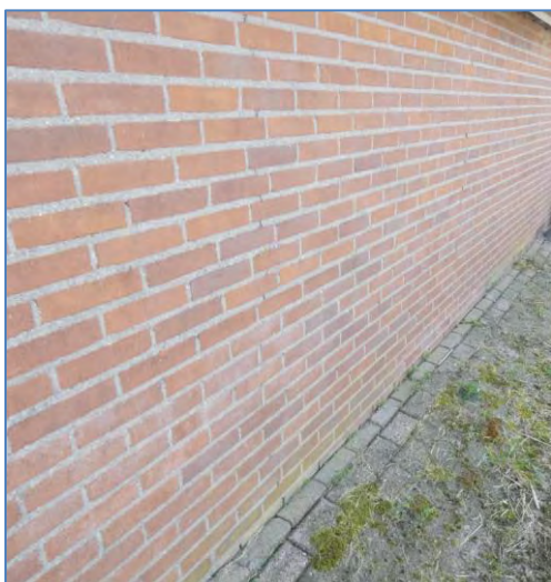
Foto 31 Zijgevel N gebouw 4 zonder open stootvoegen
