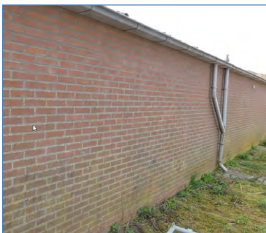
Foto 29 Zijgevel N gebouw 3 zonder open stootvoegen Foto 30 Voorgevel O gebouw 4 zonder open stootvoegen
