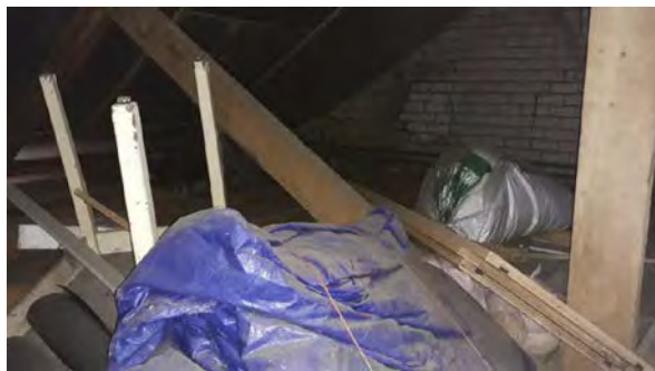
Schuur, geëxpandeerd polystyreen isolatie garage
