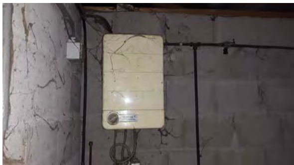
Schuur, boiler niet asbestverdacht
