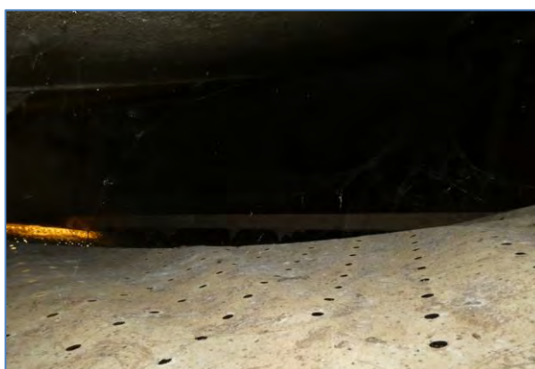
Foto 21 geheel lege tochtige ruimte boven ventilatieplafonds gebouw 1a
