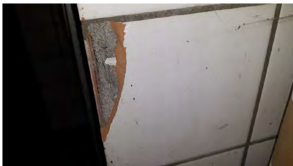
Schuur, tegels in cement gezet (geen asbestverdachte tegellijm aangetroffen)
