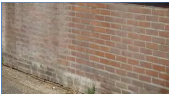
Foto 28 Zijgevel Z gebouw 1b zonder open stootvoegen
