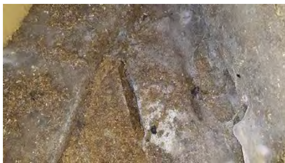
Stal 1, gangpad op betonroosters gestort
