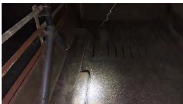
Stal 2, trog niet asbestverdacht
