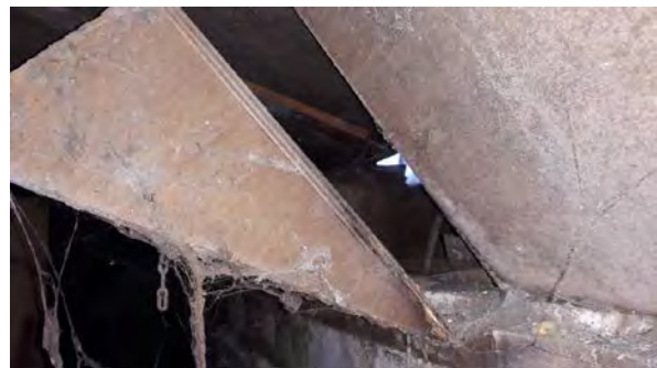
Stal 2, houten aftimmering ventilatie
