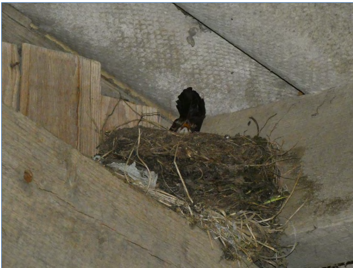
Foto 7 Broedende merel binnenzijde voorgevel gebouw 2
