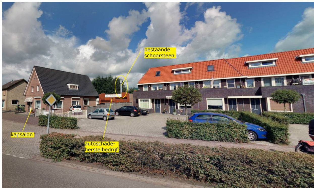
Bestaande situatie, zicht vanaf rotonde
