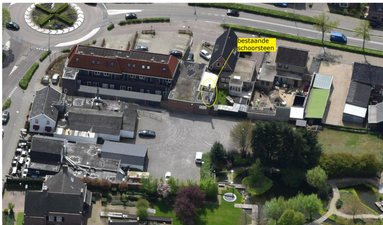
Bestaande situatie, zicht op binnenterrein
