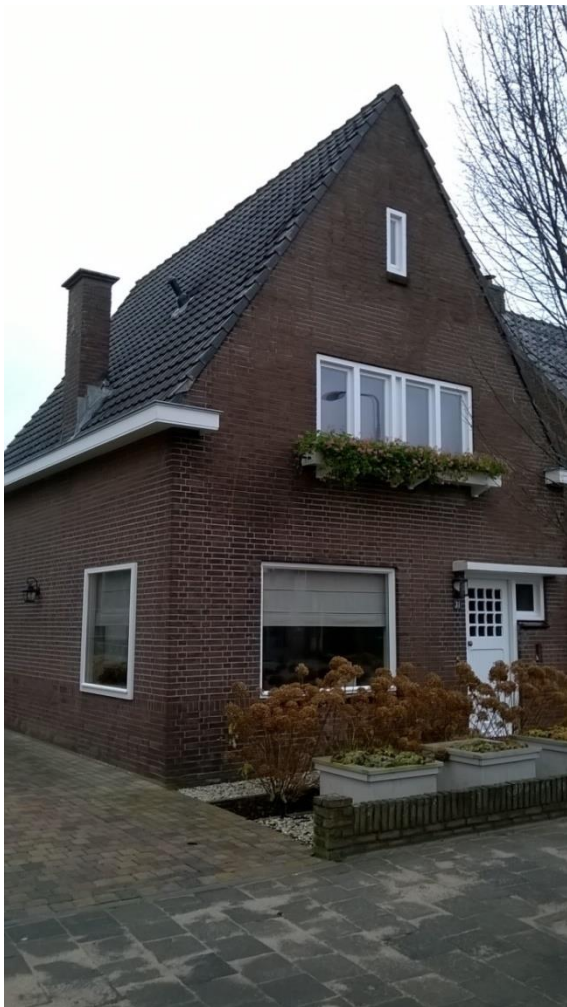
Woonhuis na renovatie
