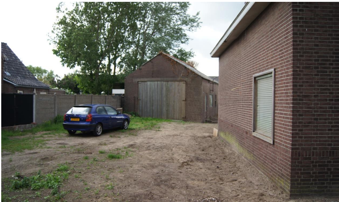
Oude situatie schuur Oijenseweg voor renovatie
