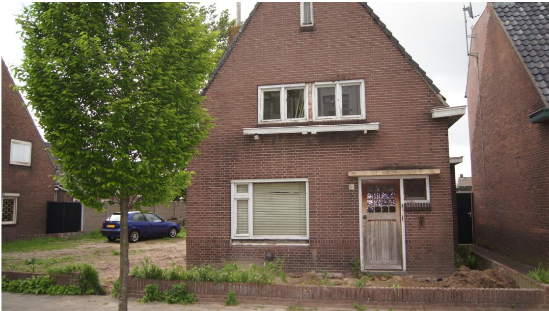
Oude situatie Oijenseweg 31 woonhuis voor renovatie.
