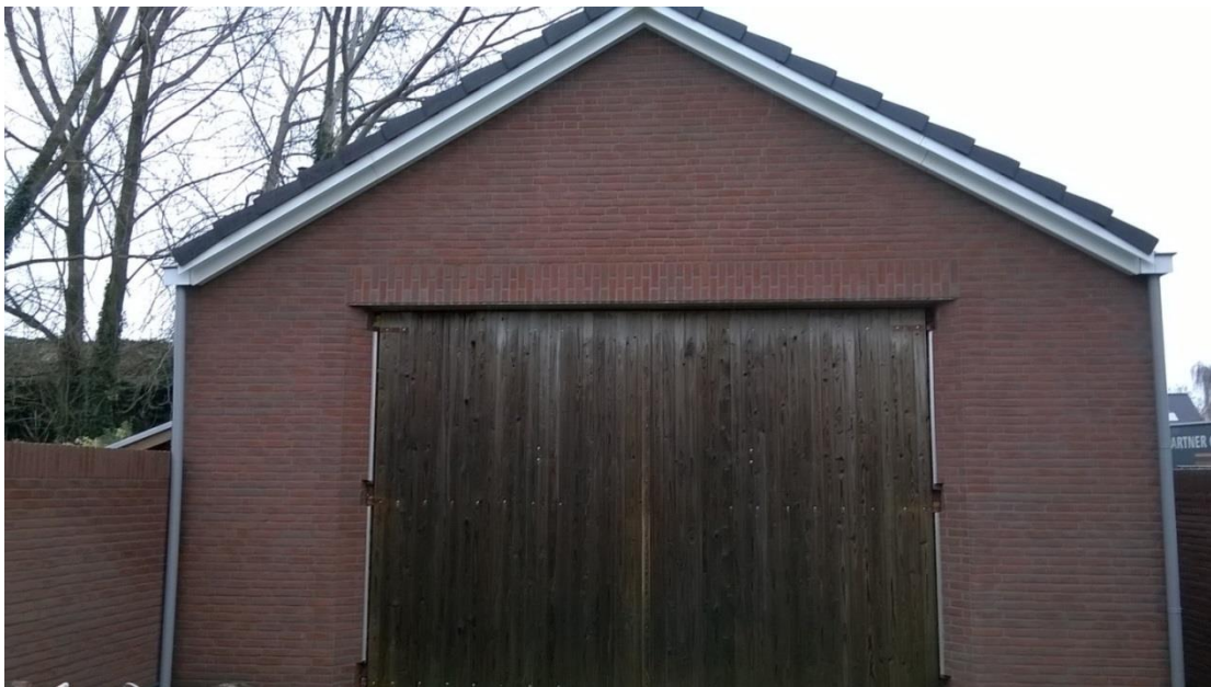
Schuur Oijenseweg na renovatie
