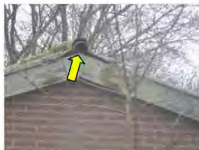
Figuur 5.3 Geschikte nestlocatie voor kerk- en steenuil in oostelijke schuur.
