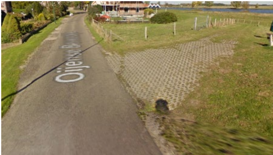
Afbeelding 1.18 Reeds aanwezige grasbetonnenstrook ter hoogte van Oijense Bovendijk 5, Oijen
