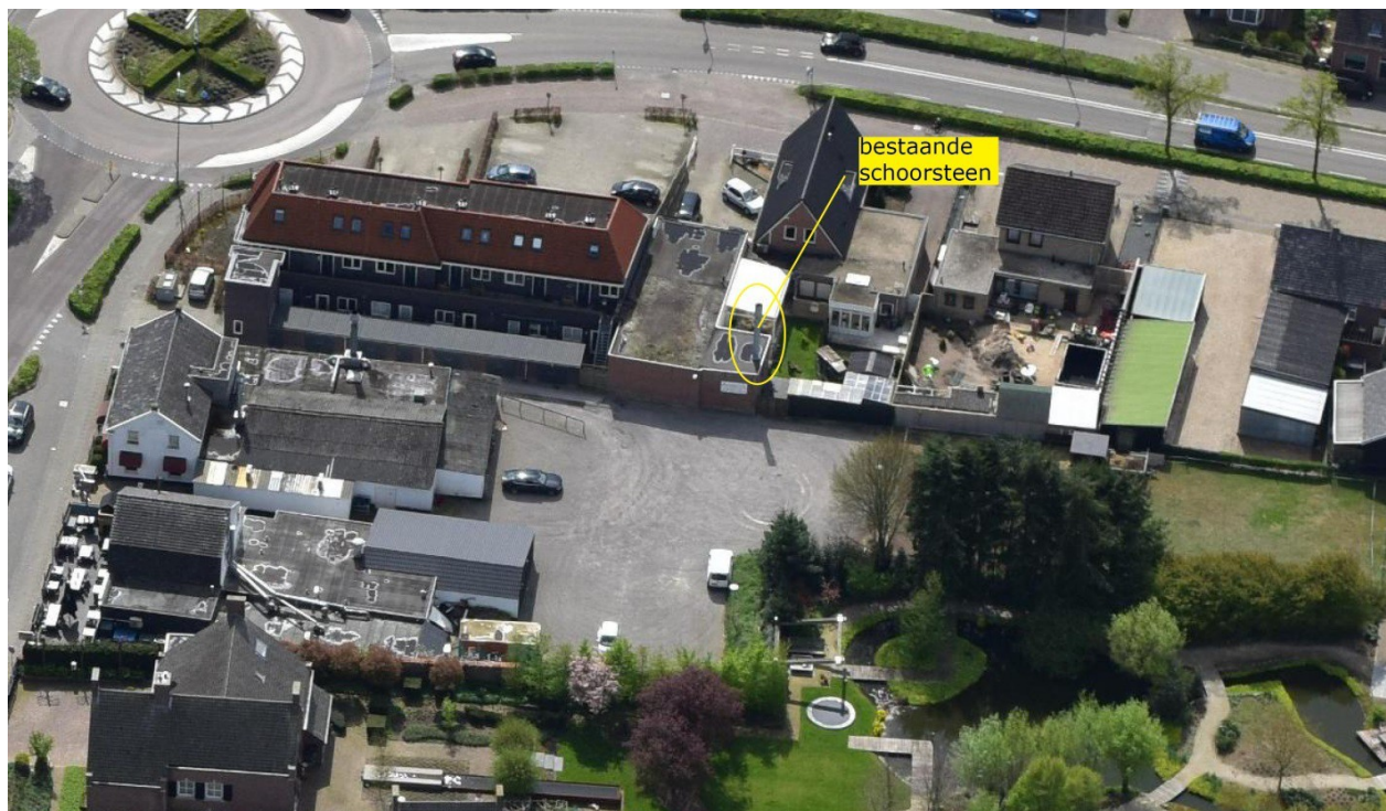
Bestaande situatie, zicht op binnenterrein
