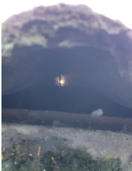
Figuur 4.2.1. De golfplaten zijn aan beide uiteindes open.
