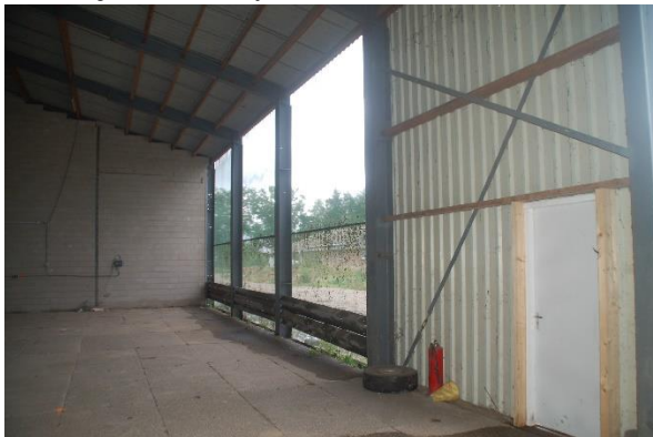
Afbeelding: loods open kant
