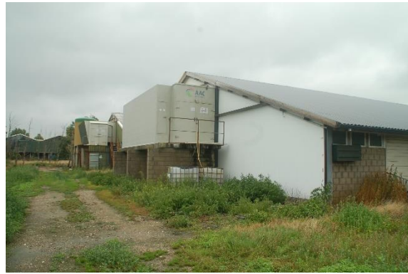
Afbeelding: luchtwasser achter stal 3
