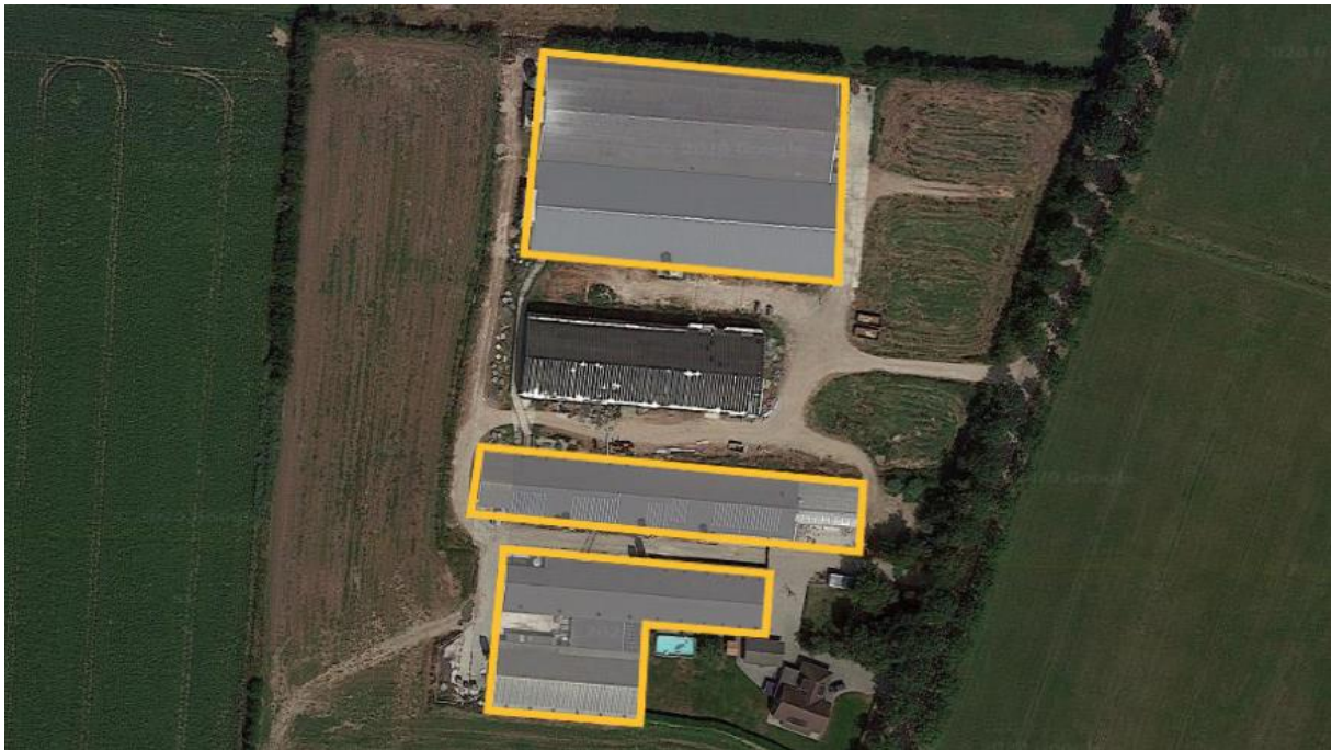
Afbeelding: de te slopen stallen bovenaanzicht
